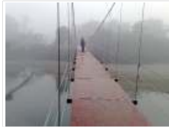
San Dam Kachin State, Myanmar 08.01.2010 71.91m ສັນດາມ໌ ກວຽນ ມြຽນມາ
